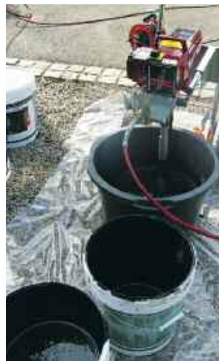
SVART: Etter rengjøring males taket med et beskyttende lag impregnering.
