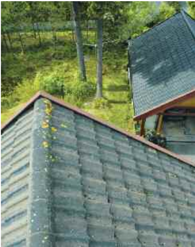
FØR OG ETTER: Garasjetaket i bakgrunnen fremstår som nytt. Hovedhuset er ennå ikke rengjort og behandlet.
